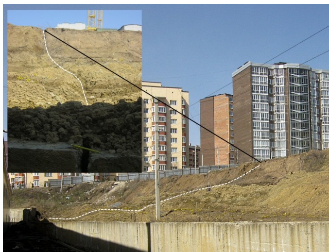
Рис. 1. Ерозійна промивина на уступі штучної тераси над ТЦ «Агора».
