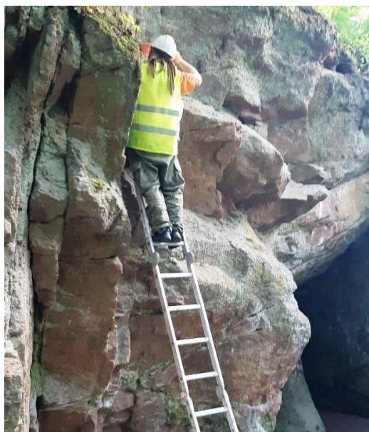
Рис. 1. Закладання деформаційних марок в тіло кам'яної брили
